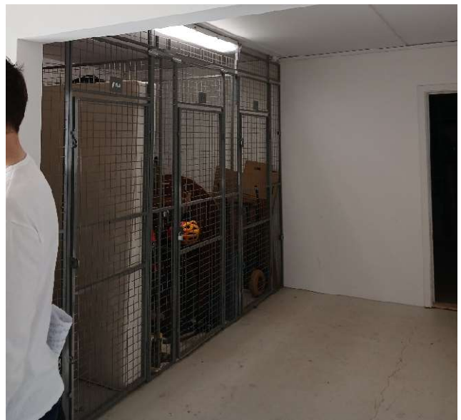
Moderne kælderrum i metalgitter, så indhold er synligt.
