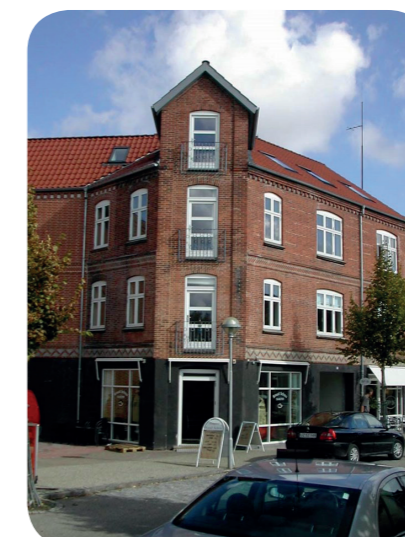
Søndergade, Hadsten Afd. 3
